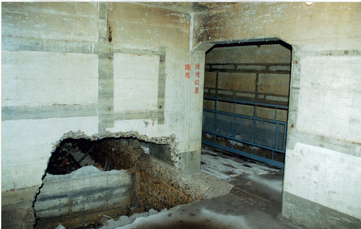
黒河の南西の北門鎮 第7国境守備隊の跡 「烟突・煖爐位置」の文字が残る
