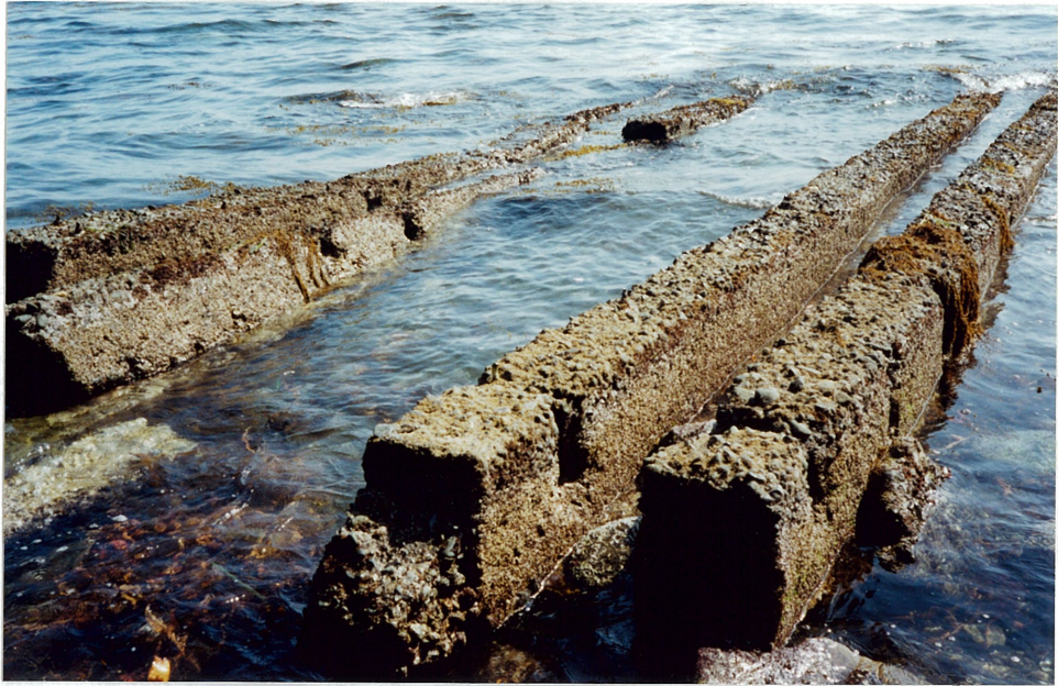
千葉県太房岬 人間魚雷回天の基地跡 コンクリート上にレールがあった
